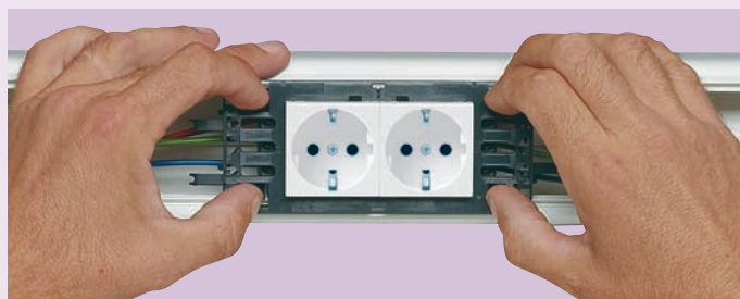
Монтаж розеток Mosaic в кабель-каналы DLP
